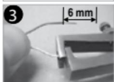
3 Dénudez l'extrémité des fils électriques (environ 6mm)
